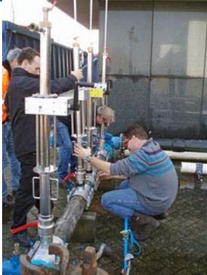
De gasblazenproef met de PVC leiding.
