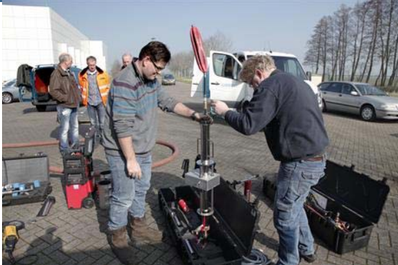
De gasblaas brengen we via een speciale stang (ook wel 'blazenzettlans' genoemd) in de leiding.
