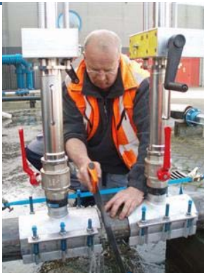
De opbouw van de tweede test is precies hetzelfde als de eerste, alleen bij deze leiding zagen we het afgesloten leidingdeel uit de leiding. Zo controleren we of de blazen daadwerkelijk het water tegenhouden.
