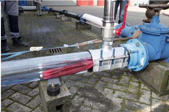
De gasblaas zit nu in de leiding en moeten we nog opblazen. Dit alles gebeurt onder een normale waterdruk van 3,6 bar.
