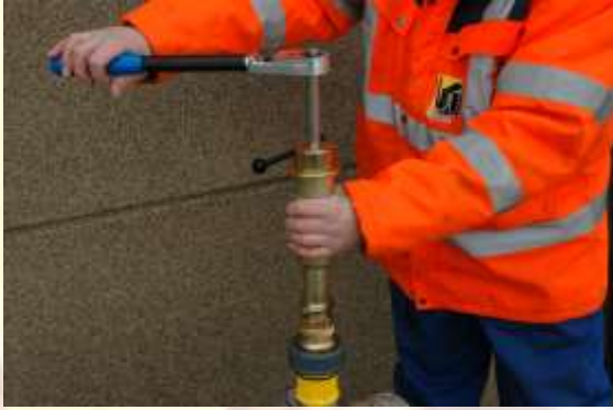
19. En begin met het aanboren van de leiding.
