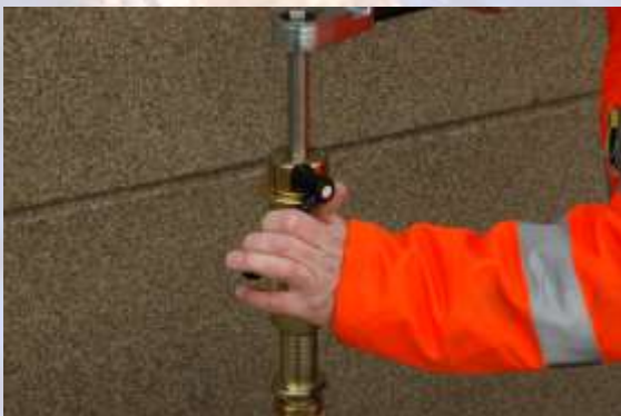
20. U bent klaar met aanboren.
