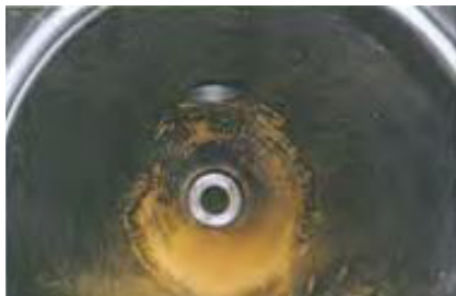
Fig. 7. Zand als plaatsvervanger voor gasstof in PE-buis. Boven: boring voor blaasinbrengapparaat.
