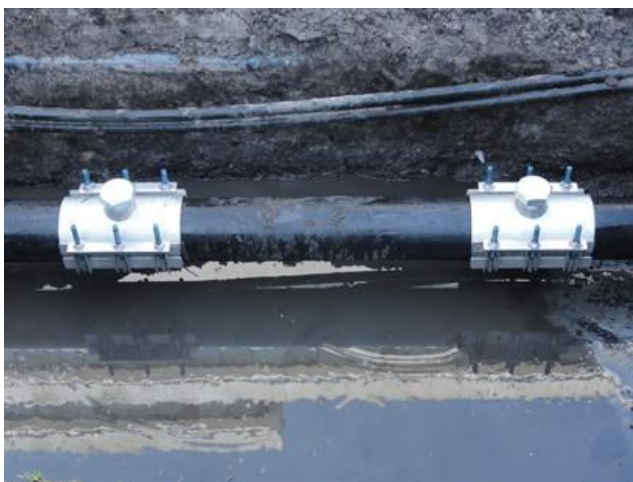
Na het afdoppen van het zadel kan de werksleuf weer dicht.
