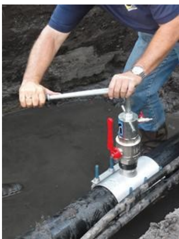
Via het opzetstuk draaien we een afsluitdop op het zadel.
