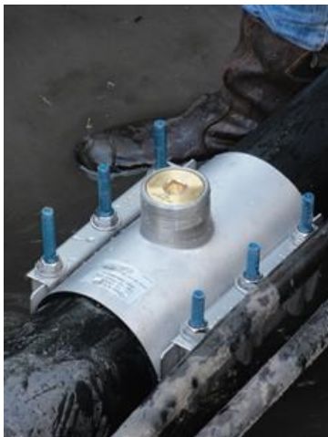
De afsluitdop op het zadel. Deze kunnen we later weer gebruiken als het nodig is om in de leiding te werken.
