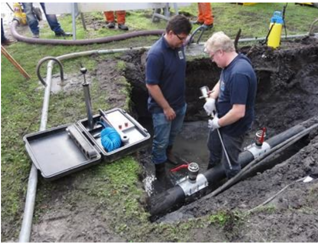
Na de aanboring sluiten we de kogelkraan op het zadel.
