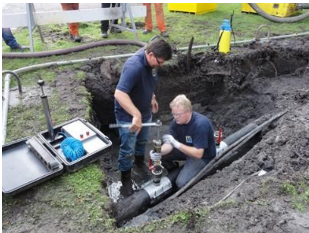
Via de zadels maken we een aanboring op de leiding.
