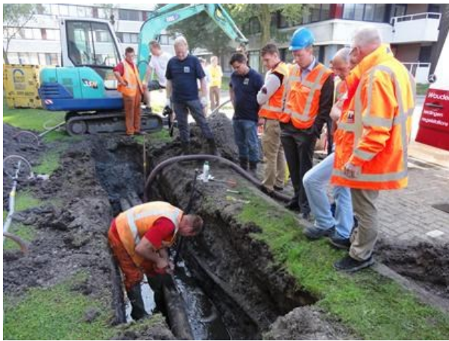
Nu de gasblazen zijn gevuld en het leidingdeel is afgesloten kunnen we verder aan de leiding werken.
