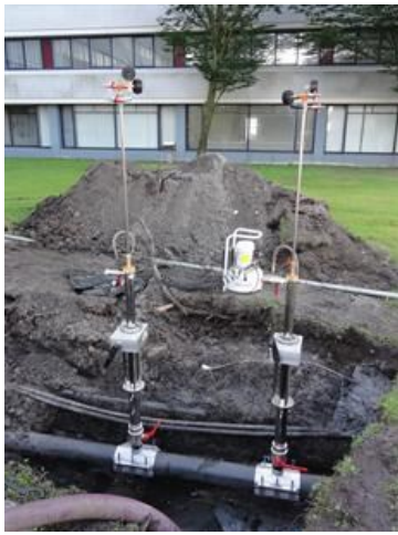
De opzetstukken met de gasblazen plaatsen we op de zadels.
