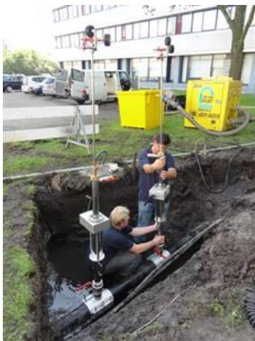
Als het werk klaar is laten we de gasblazen leeg lopen en nemen we ze uit de leiding.
