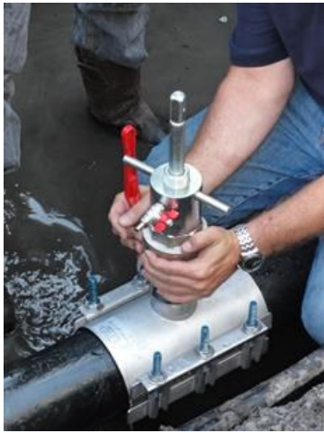
Vervolgens verwijderen we het opzetstuk van het zadel.
