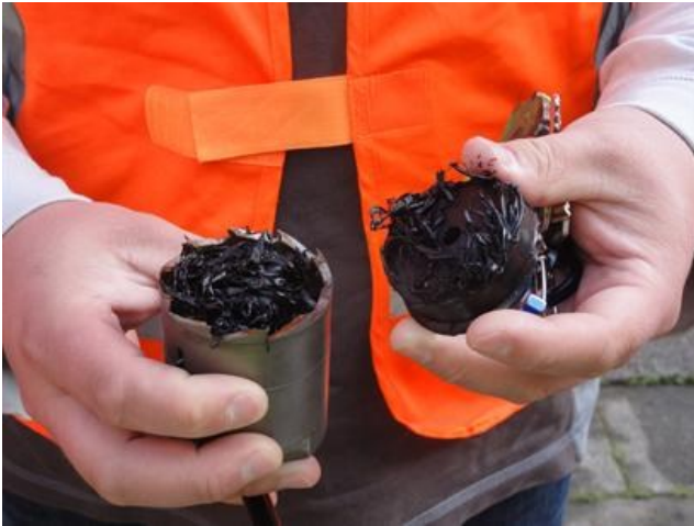
Het slijpsel van de leiding komt keurig mee in de aanboorkop, zo blijft er geen slijpsel in de leiding achter.
