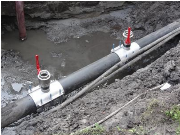
Voor de veiligheid plaatsen we twee zadels op de leiding. Als er met de ene iets gebeurt, hebben we de ander als backup.
